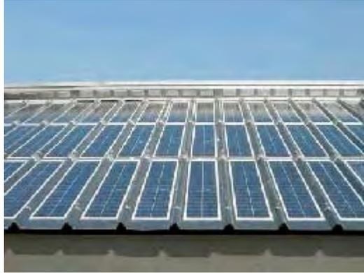
b- L'équipement de production d'électricité photovoltaïque comprend les rails de fixation et les modules photovoltaïques (l'ensemble a été conçu industriellement et spécifiquement pour cette application).
